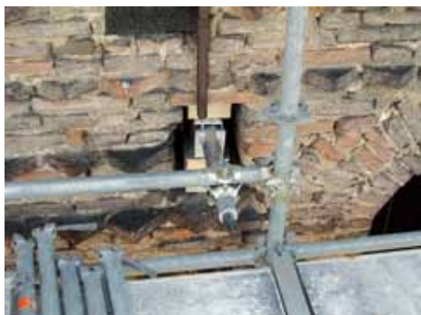
Particolari del sistema di ancoraggio. Gli ancoraggi "primari" sono stati realizzati utilizzando le Buche Pontaie lasciate nella facciata dai Costruttori nel lontano 1600
