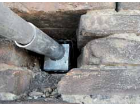
Particolari del sistema di ancoraggio. Gli ancoraggi "primari" sono stati realizzati utilizzando le Buche Pontaie lasciate nella facciata dai Costruttori nel lontano 1600
