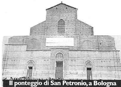
Il ponteggio di San Petronio, a Bologna
